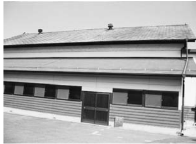
葺き替え前の全景
