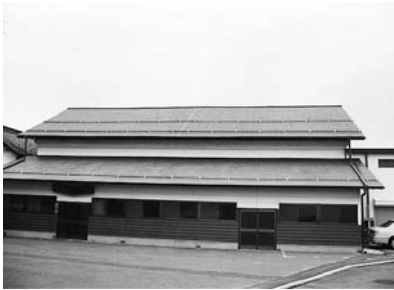
仕上がり全景
